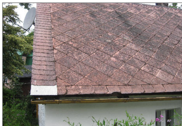
Fot. 2 Płyty azbestowo-cementowe płaskie
